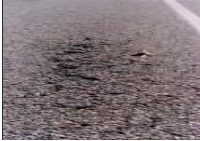
Şekil 5.14. Sökülme örneği
