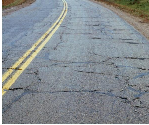
Şekil 2.27. Blok kırılması
