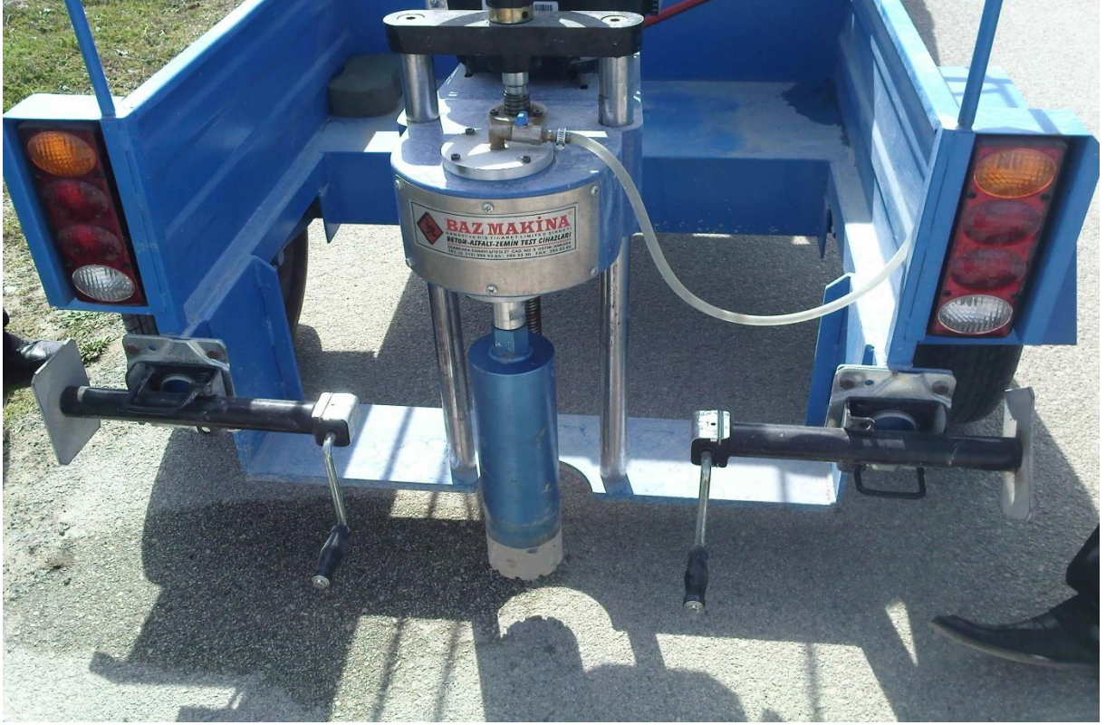
Şekil 8.12. Asfalt karot numunelerin alınması
