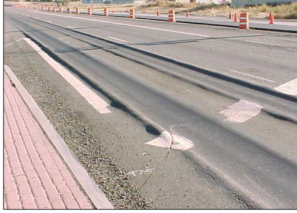
Şekil 5.5. Tekerlek izinde orta önemde boyuna kırılma
