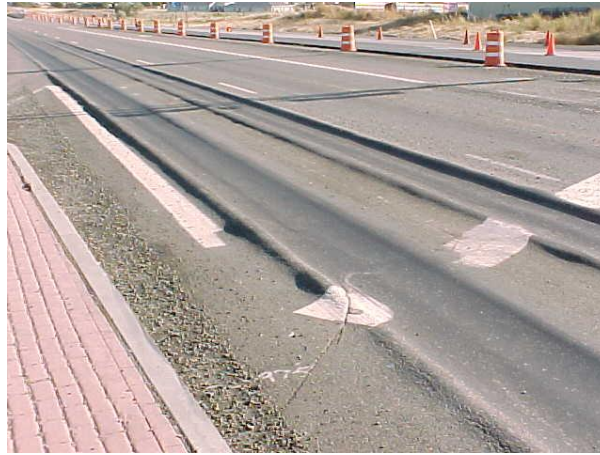
Şekil 2.29. Tekerlek izinde orta önemde boyuna kırılma
