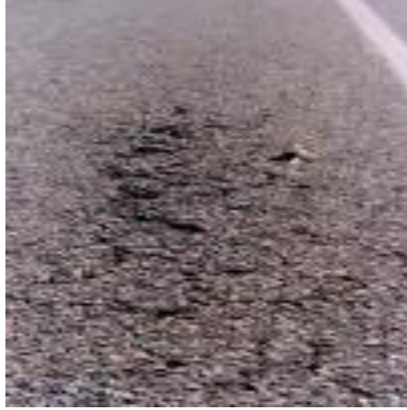
Şekil 2.38. Sökülme örneği
