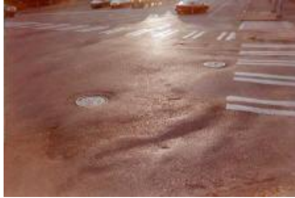
Şekil 2.35. Ondülasyon ve yığılma
