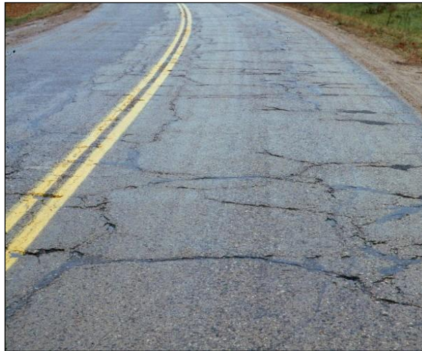
Şekil 5.3. Blok kırılması
