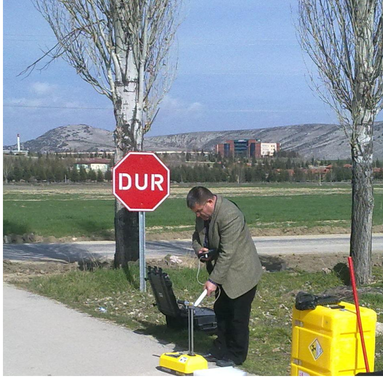
Şekil 8.5. Radyoaktif yöntemle asfalt beton yoğunluğu tayini
