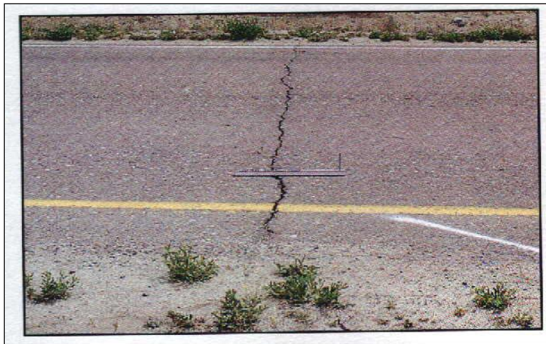
Şekil 5.8. Yüksek önemli enine kırılma
