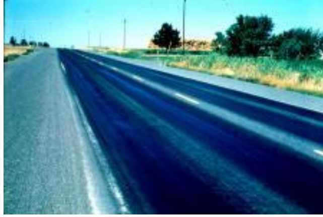
Şekil 2.36. Yüksek önemde kismada açıkça görülen tekerlek izleri
