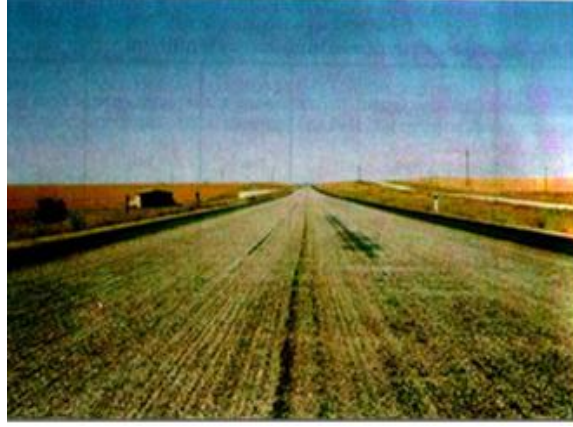
Şekil 5.16. Tarak şeklinde boyuna çizgiler
