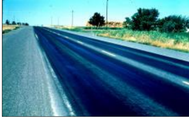
Şekil 5.12. Yüksek önemde kismada açıkça görülen tekerlek izleri
