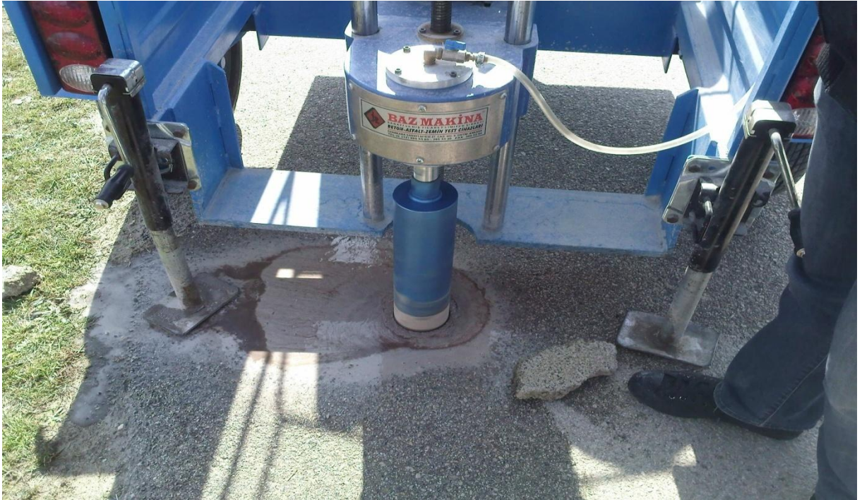
Şekil 8.13. Asfalt karot numunelerin alınması
