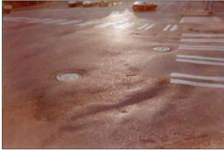
Şekil 5.11. Ondülasyon ve yığılma
